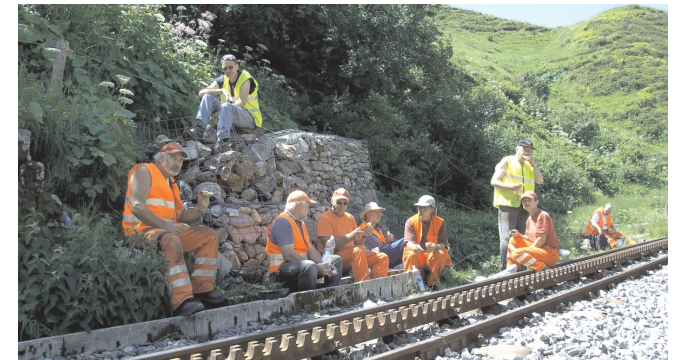
Pause bei Unterhaltsarbeiten
